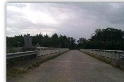
Fig. 191. PONT AU-DESSUS DE LA ROCADE MENANT A LA CHAUVINAIS (SOURCE : EVEN CONSEIL, 2012)
