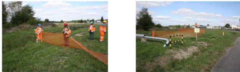
Exemple de mise en place d'un balisage d'un site sensible vis-à-vis d'un projet d'aménagement (Source : © Biotope)
