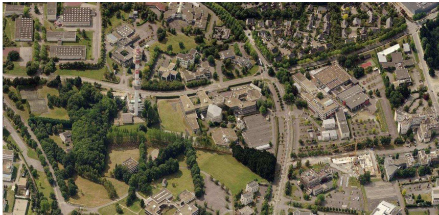
Fig. 111. VUE SUR ATALANTE SUD
