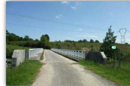
Fig. 190. PONT AU-DESSUS DE LA ROCADE MENANT A THORIGNE-FOUILLARD (SOURCE : EVEN CONSEIL, 2012)
