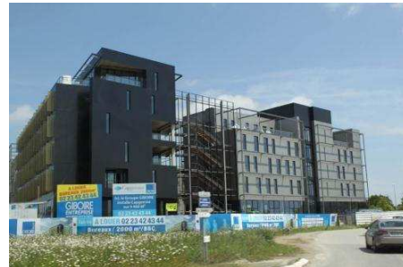
Construction des Champs Blancs (Source : EVEN Conseil, 2012)
